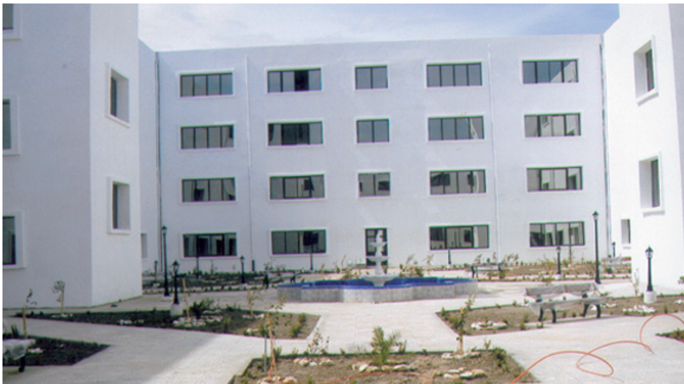
Aménagement extérieur de l'institut de pharmacie
